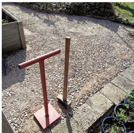
*Der Kalksteinschotter wird immer wieder mit dem Stampfer verdichtet. Der Vorschlaghammer ist zum Verdichten an den Kanten geeignet.*
