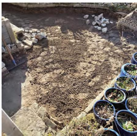
*Der Boden wird zirka 15 bis 20 Zentimeter ausgeschachtet.*
